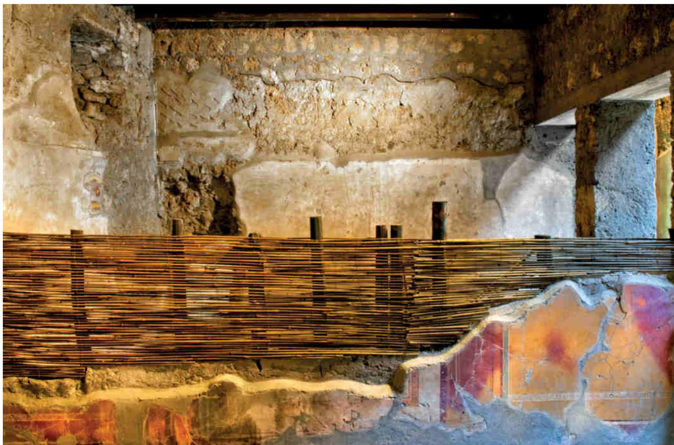
Fig. 3 – Ambienti U-Y. Tramezzo in incannucciata decorato in Quarto Stile con vistose tracce, nella zona mediana, del viraggio del colore giallo in rosso per il forte calore dei *surges*.
